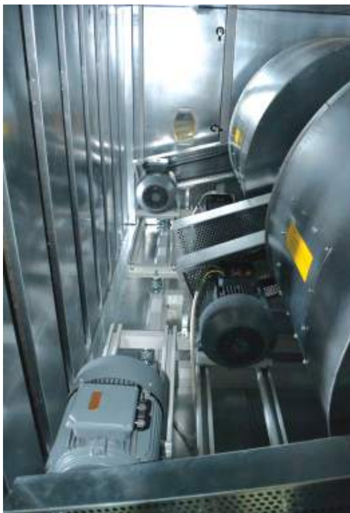
Dual fan and run & standby motor
